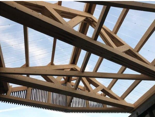
Abb. 15 - Dachkonstruktion aus Fichtendübeln in Épinal [U Lorraine].
