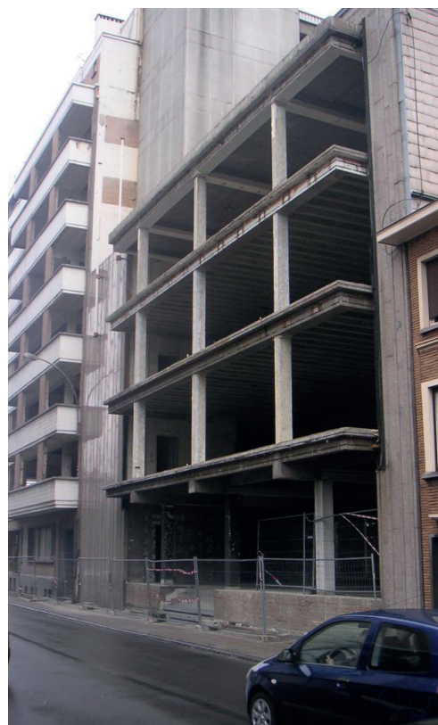
Bâtiments désossés: façades à rue Source : A.A.V.T.
