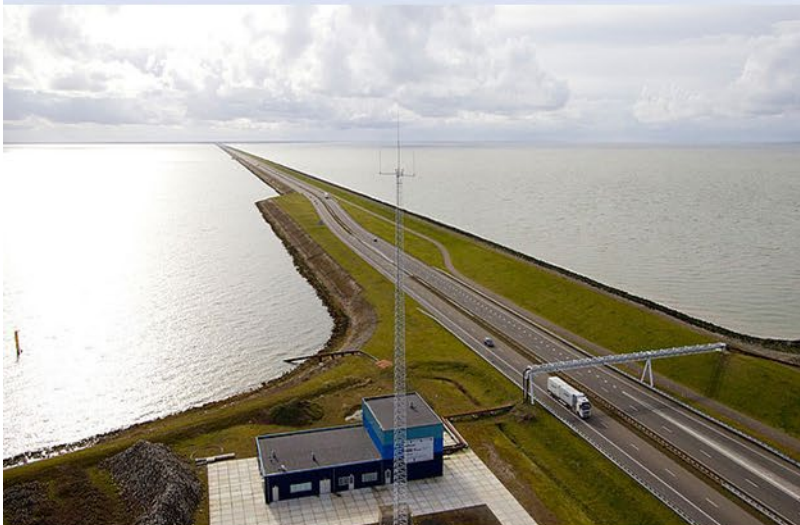
Salinity gradient plant from REDstack in Afsluitdijk
