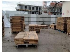
Réemploi de chantier à chantier (Villeurbanne) : plus-value à la dépose de 25€/m<sup>2</sup> VS fourniture neuf équivalente de 80€/m<sup>2</sup>
