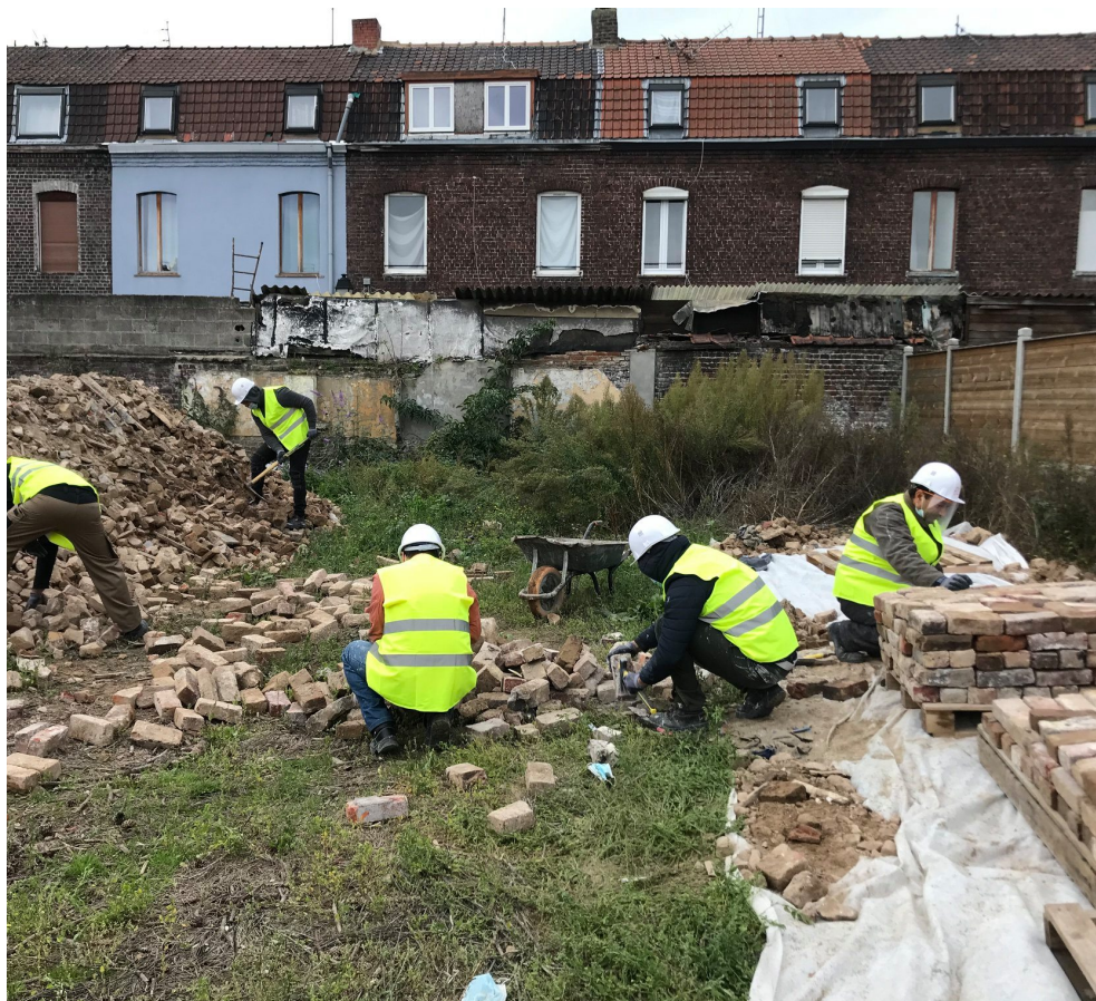
Récupération de briques issues d'une démolition © La Fabrique des Quartiers
