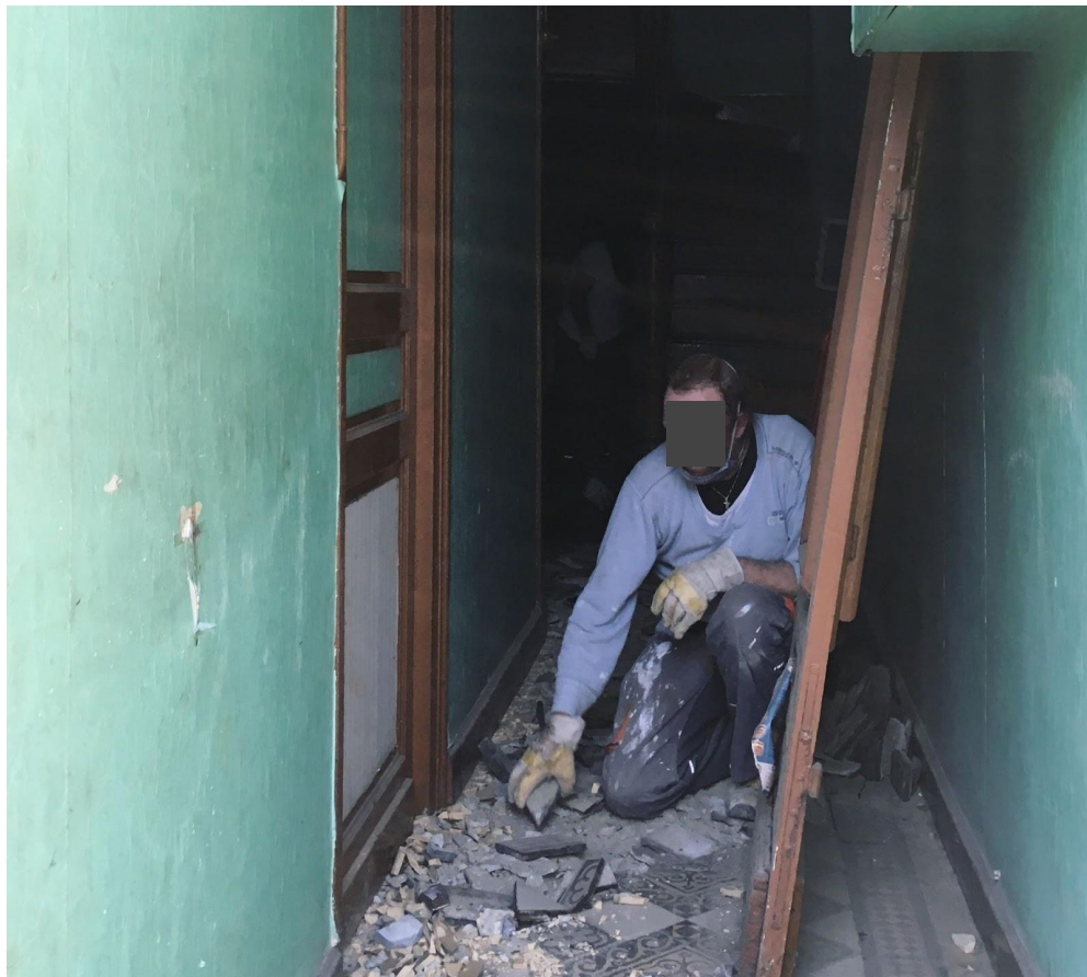
< Ouvrier déposant du carrelage © La Fabrique des Quartiers
