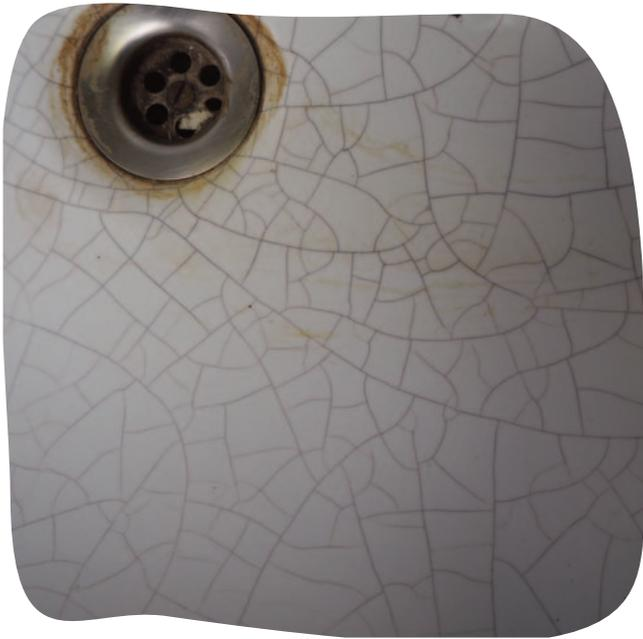
*Accumulation de calcaire et dégâts de l'eau sur un évier récupéré et tressillage*
