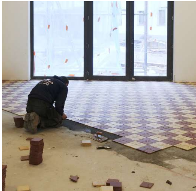
1) Illustration des principes du réemploi à travers le cas de figure d'un revêtement de sol en carrelage : démontage soigneux, transport, nettoyage, conditionnement et repose.
