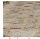
Photo : Entreprise Guedes
