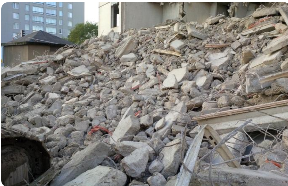
Brokstukken betonpuin bij de afbraak van een toren in Clos Saint Lazare in Stains (FR).
