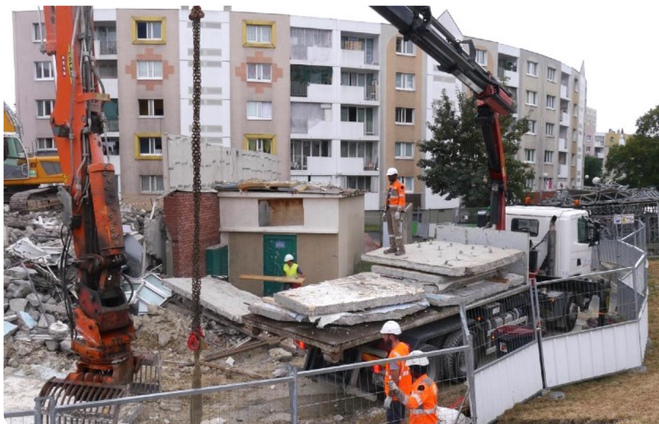
Transport van betonnen elementen
