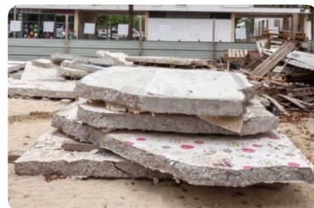
Voorbeeld van een gedemonteerde betonnen wand © Alexis Leclercq
