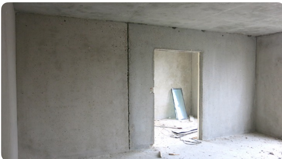
Geprefabriceerde binnenwanden, na verwijdering van muurbekleding en asbestwerkzaamheden, voor afbraak of ontmanteling van het gebouw.
