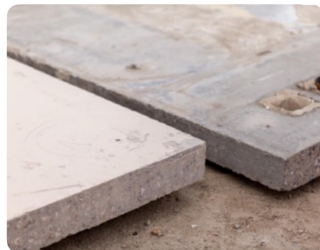
Verzagen van gerecupereerde betonwanden voor hergebruik © Alexis Leclercq
