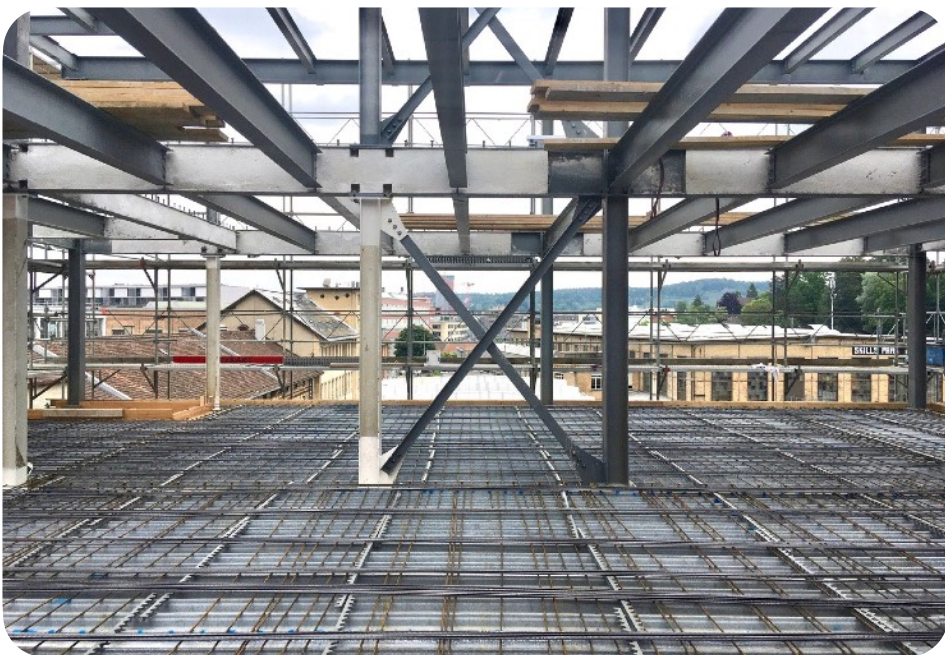
Hergebruik van de liggers
