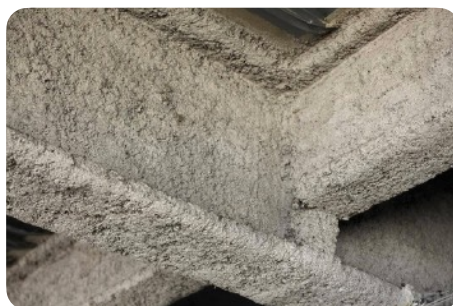
Liggers voorzien van een brandwerende bescherming in de vorm van flocking
