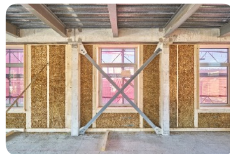
Hergebruik van de liggers
