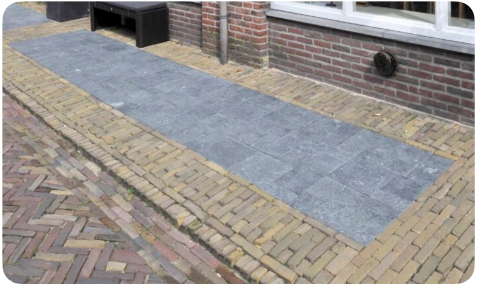
Renovatie van bestrating met hergebruikklinkers, Bergen (NL), 2020 © Stone Base
