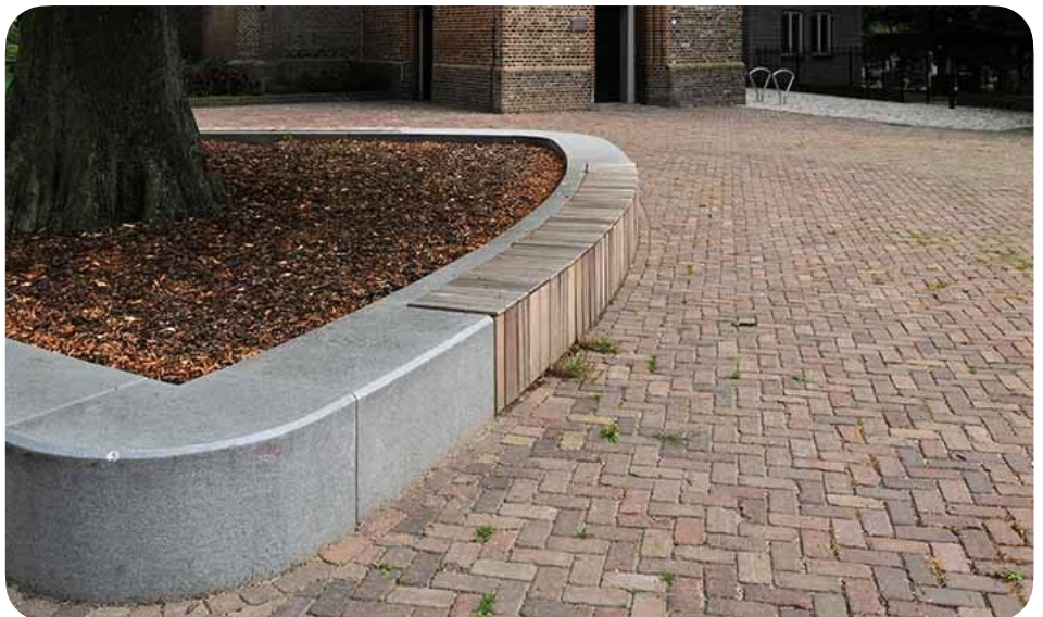
Aanleg van een plein met hergebruikklinkers, Macharen (NL), 2020 © Stone Base
