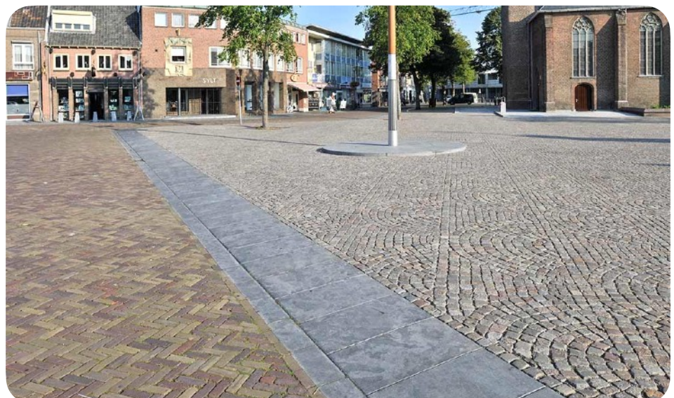
Aanleg van een plein met hergebruikklinkers, Schijndel (NL), 2020 © Stone Base
