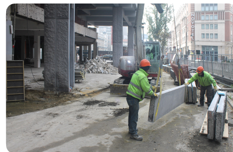
Démontage d'éléments en pierre
