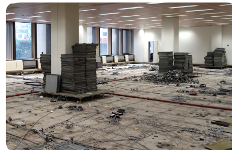
Démontage de plancher technique
