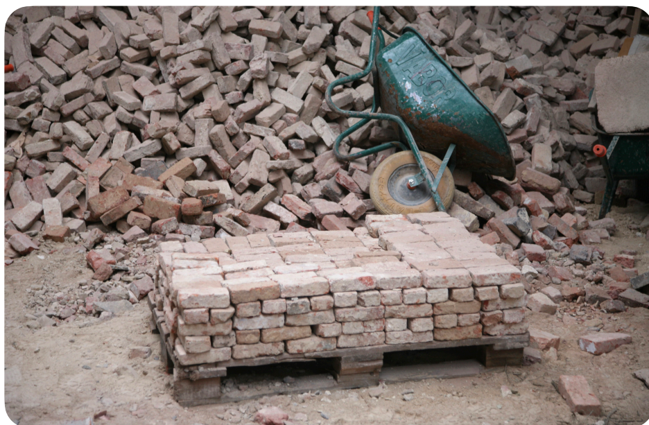
Nettoyage et tri de briques récupérées
