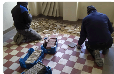
Démontage de carreaux en céramique
