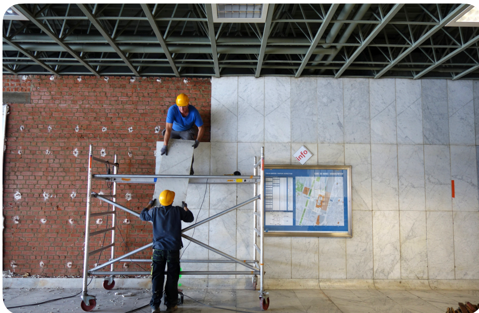
Démontage soigneux de éléments
