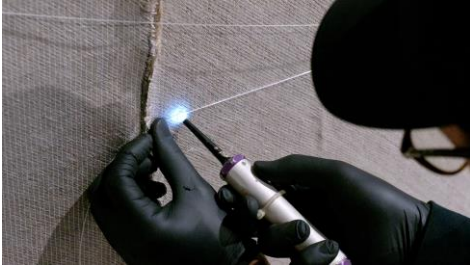
Bauwerksüberwachung: Die Daten von fast 100 Sensoren werden durch Künstliche Intelligenz in Echtzeit ausgewertet. Das Bild zeigt den Einbau von faseroptischen Sensoren.
