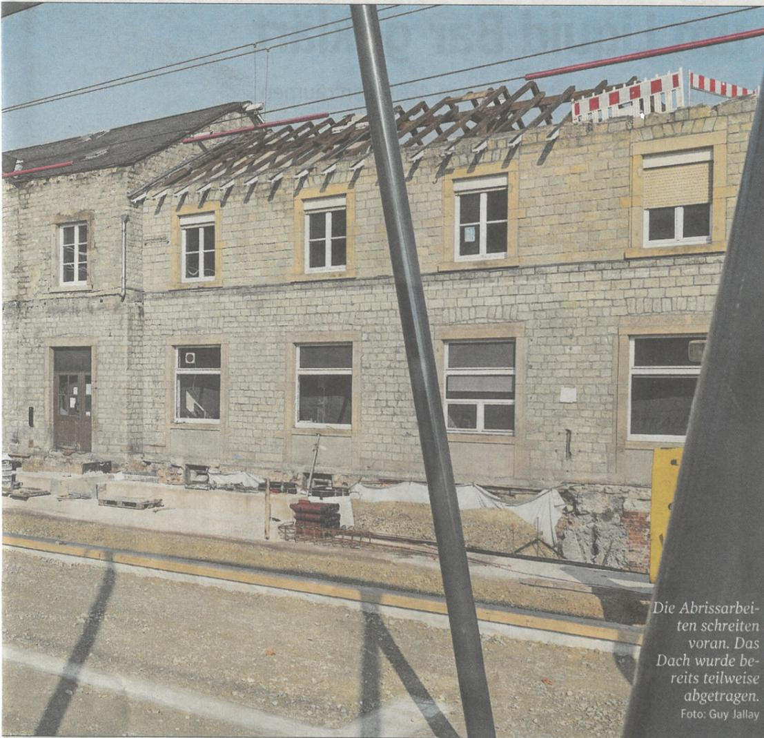
Die Abrissarbeiten schreiten voran. Das Dach wurde bereits teilweise abgetragen.
