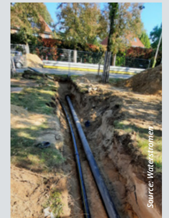
Une tuyauterie distincte a été installée entre la papeterie et la station d'épuration. Les eaux usées sont transportées vers la station d'épuration et le biogaz est renvoyé vers le consommateur industriel.
