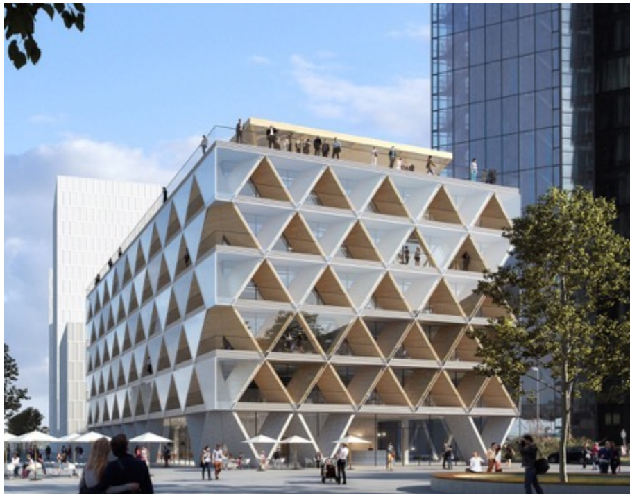
THE CRADLE Düsseldorf Interboden / HPP Architekten
