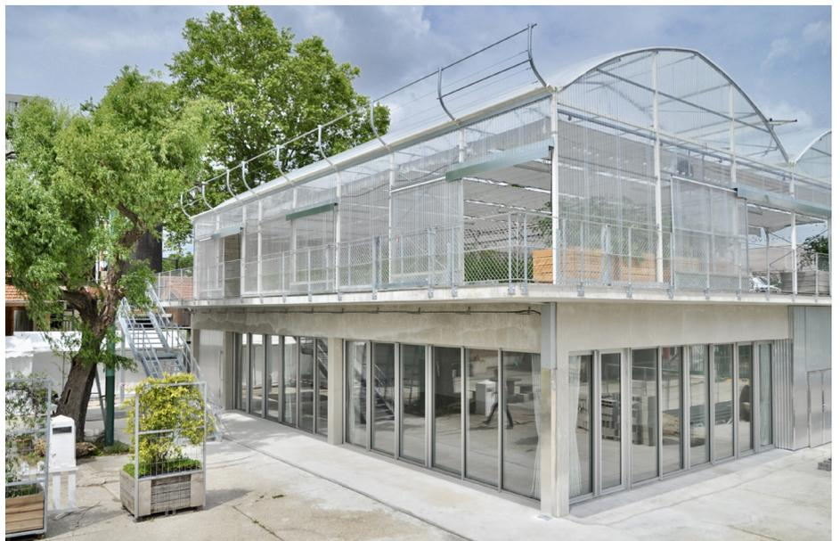
Pour la culture de végétaux, la lumière naturelle est indispensable et doit être maximale. Les serres horticoles sont conçues et adaptées pour cette utilisation. Totalement transparentes et dotées d'ouvrants de ventilation et de rideaux d'ombrage pour contrôler le climat intérieur, elles utilisent la lumière du soleil, pour créer un micro-climat et permettre ainsi aux plantes de se développer.
