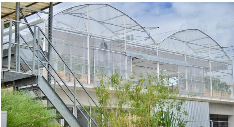
La serre est une serre horticole standard, dont la seule particularité est d'être construite sur une plateforme en béton et non directement sur le sol.
