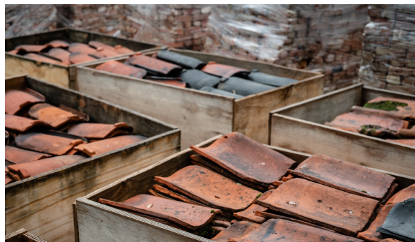
Les tuiles ont été démontées, nettoyées, emballées et stockées. Elles sont prêtes à être réemployées
