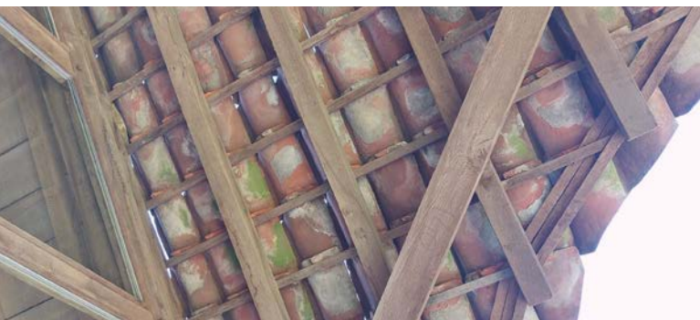
Voorbeeld van toepassing van recuperatiepannen (Vlaamse pannen) op een gebouw uit 1741, herbouwd op KampC in Westerlo; bemerk de gereduceerde neerslagdichtheid van de dakbedekking omwille van de geringere maatvastheid van de pannen; de rol van het onderdak wordt dus zeer belangrijk.
