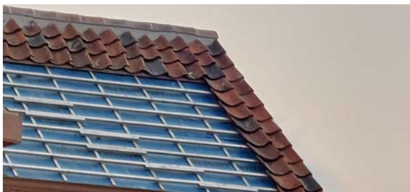
Voorbeeld van de bevestiging van nokpannen op de traditionele manier (met mortel) i.k.v. een recente dakrenovatie (2023) met behoud van het authentieke uitzicht (© F. Dobbels)
