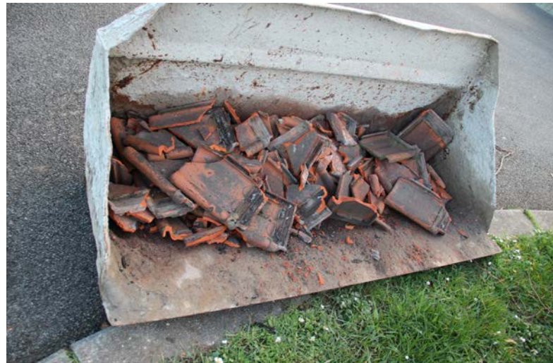
Voorbeeld van het uitsorteren van niet-herbruikbare reststukken van dakpannen bij demontage
