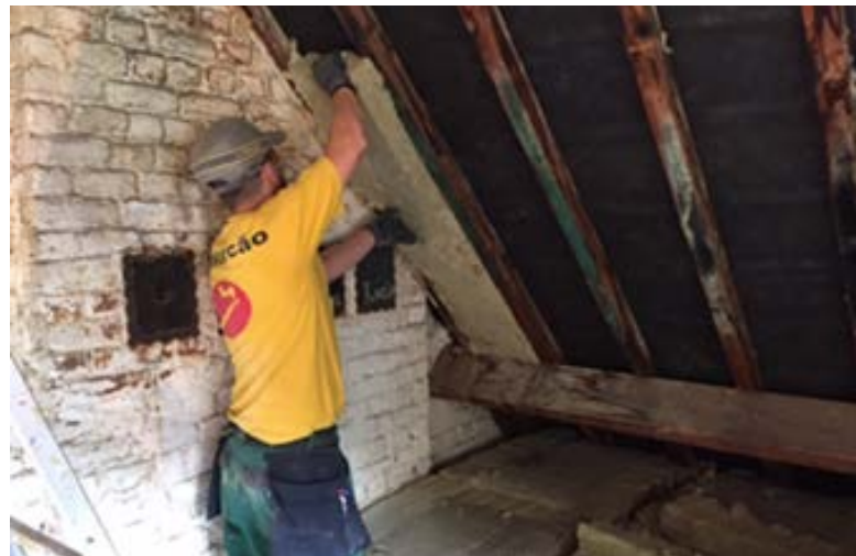
Herplaatsing van isolatie in minerale wol afkomstig van de binnenwanden van een kantoorgebouw in Brussel (ONSS)
