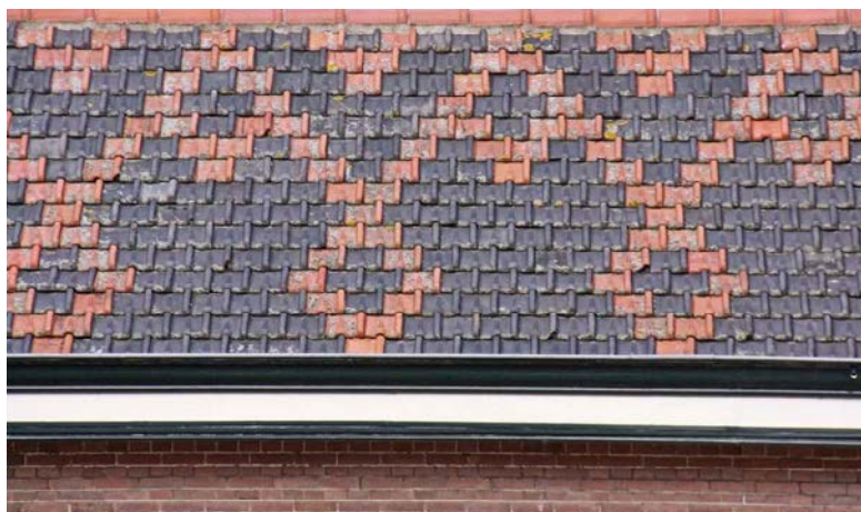
Praktijkvoorbeeld van creatief gebruik van kleine hoeveelheden recuperatiepannen: combinatie met andere pannen (andere kleur). Loods bij het station van Medemblik aan de museumspoorlijn van Hoorn naar Medemblik.
