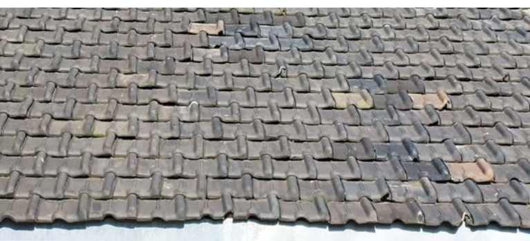
Voorbeeld van toepassing van recuperatiepannen, illustratie van de geringere maatvastheid, met impact op de esthetiek (rechte lijnen soms moeilijker te realiseren)
