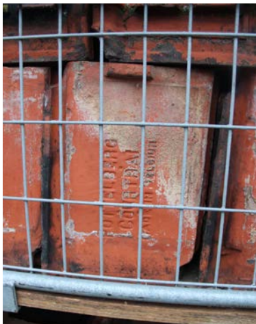
Voorbeeld van vermelding van de herkomst van een pan op de achterzijde van de pan
