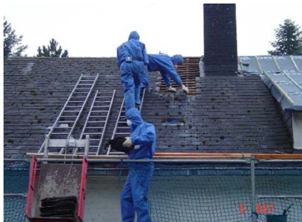
Ontmanteling van een dak met asbesthoudende kunstleien (foto D. Nicaise, 2008)
