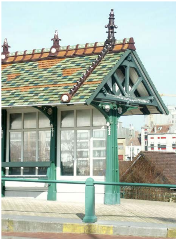
Voorbeeld van dakpannen die 115 jaar in gebruik zijn: Paravent van Blankenberge (gedeelte vernieuwd in 1993)
