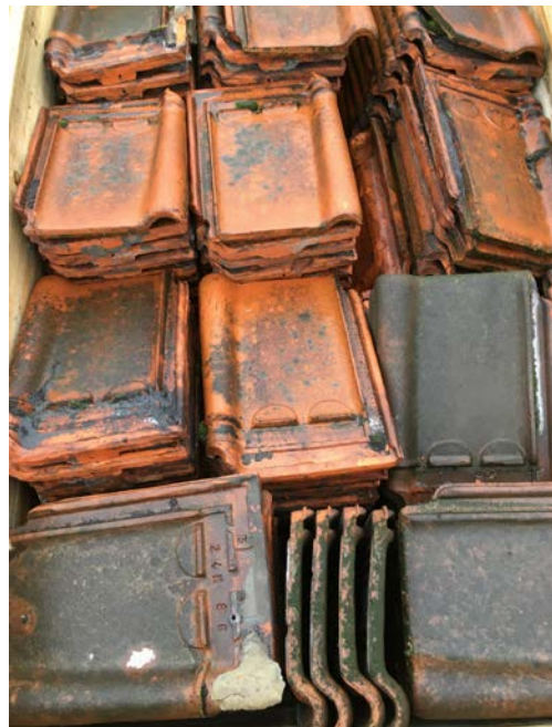
Voorbeeld van het uitzicht van pannen na demontage van een dak
