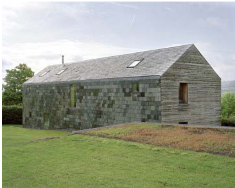
Concreet voorbeeld van hergebruik van dakbedekkingsproducten (natuurleien): Zie https://opalis.eu/nl/inspiration/5599
