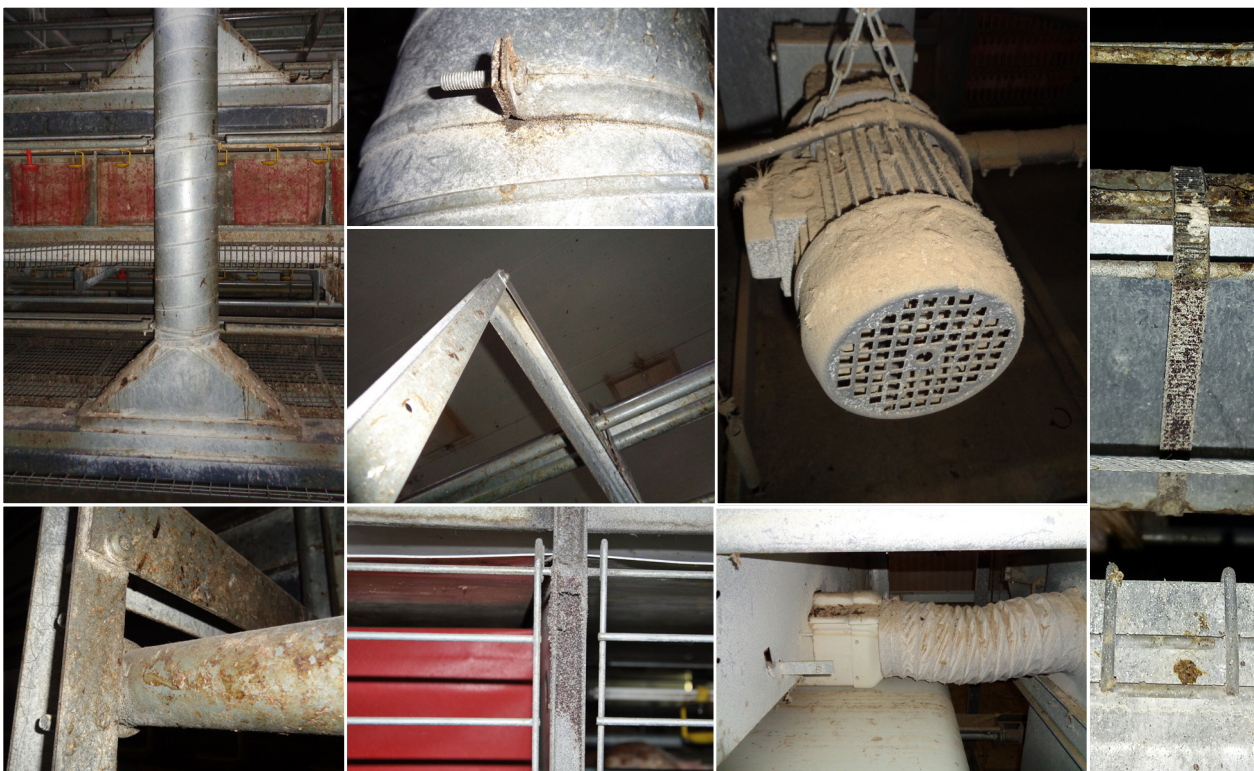
Figur 4: Beispiele für Bereiche, die einer gründlichen Reinigung bedürfen, wie z. B. Kotbandbelüftungssystem, Motoren, Schläuche, Verbindungen, Stützstrukturen, Kabelbinder
