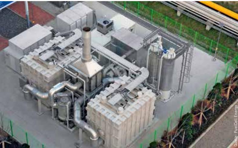
Abb. 3: SureSource 3000, bestehend aus zwei 1,4-MW-Modulen
