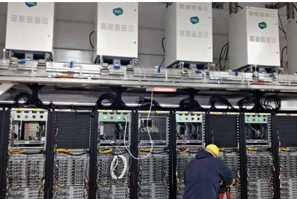
Abb. 1: Oben die BZ-Geräte – direkt darunter die Server [Quelle: SOLIDpower]
