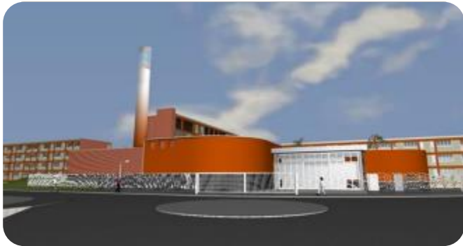
Chaufferie Chemin Vert
